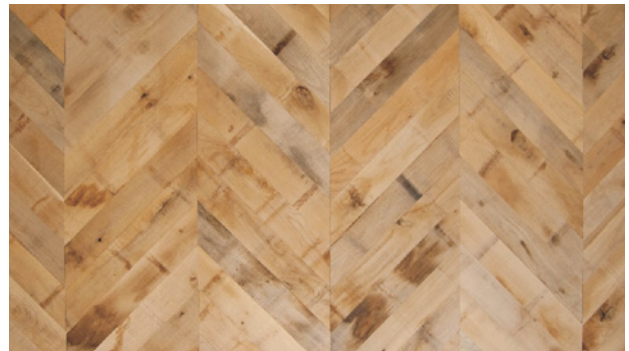
写真2 フレンチヘリンボーン
