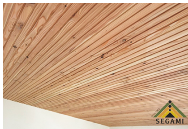
写真3 リブを設けたカラマツ天井材
