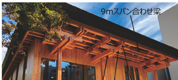
9mスパン合わせ梁 合わせ桁梁 柱頭斗拱梁 せん断補強梁
