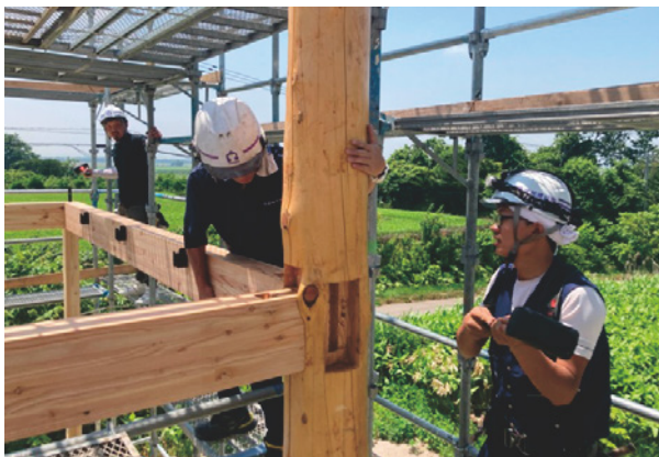
写真2 伐採した丸太の施工
